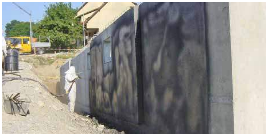
Application d'un revêtement de bitume épais modifié par matières plastiques
