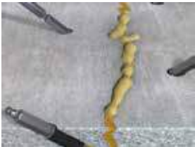
Disposition des garnitures de perçage
