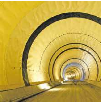
Étanchéité de tunnel
