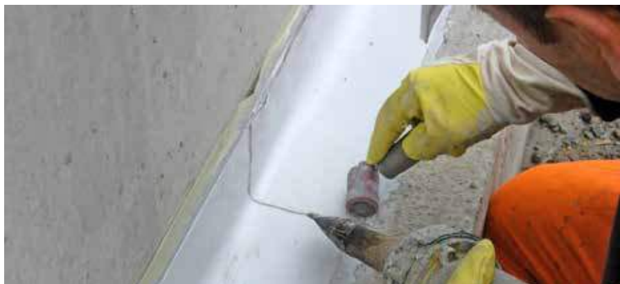
Soudage du système Sikadur-Combiflex® SG
