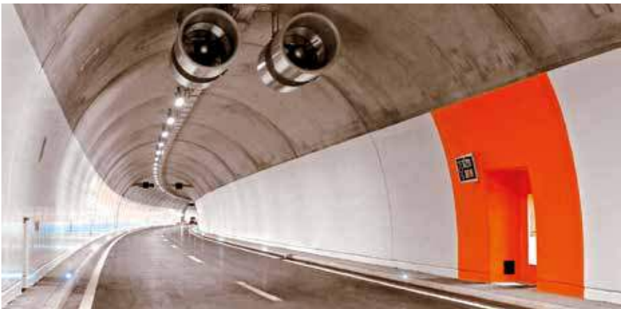
Tunnel routier terminé
