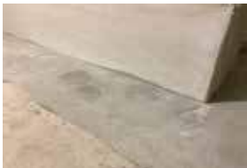
Reprofilage du revêtement de sol
