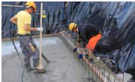
Bétonnage de la plaque de fond
