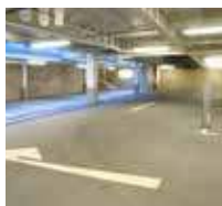
Parois de parkings souterrains
