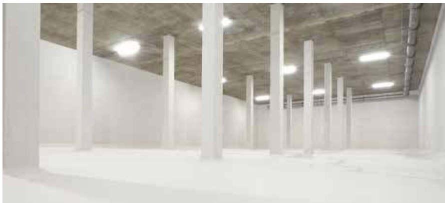
Revêtement à base de ciment pour réservoir
