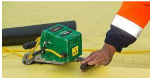
Soudage de membranes d'étanchéité en plastique
