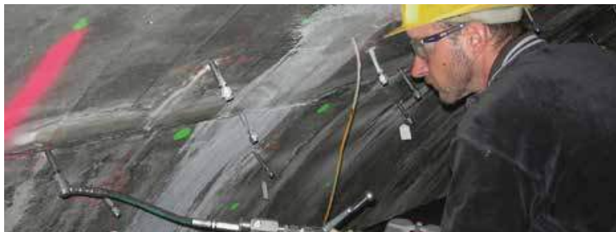
Scellement des fissures
