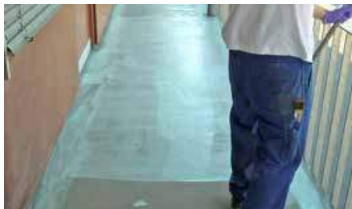
Application d'un revêtement pour balcon
