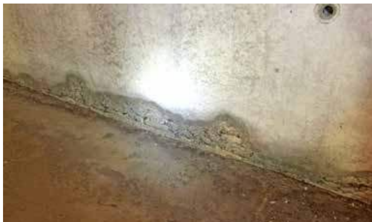
Nids de gravier au niveau du socle
