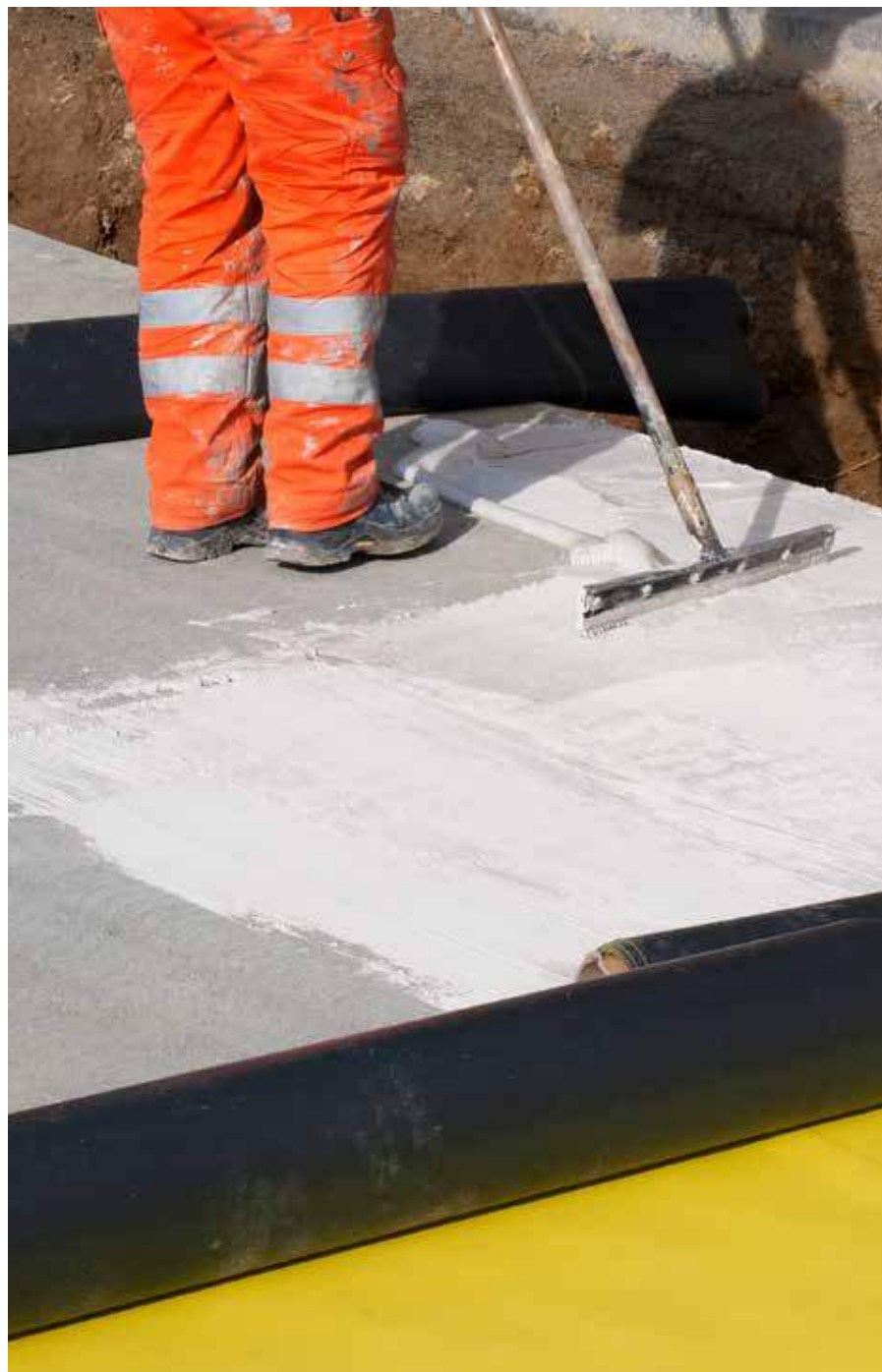
Collage de membranes d'étanchéité en plastique sur toute la surface
