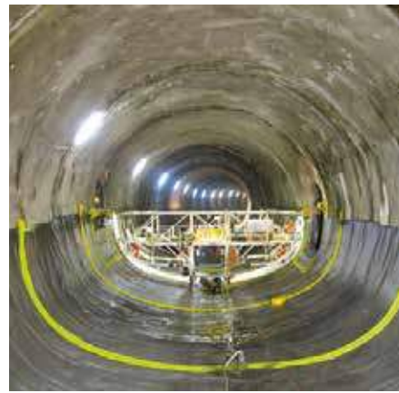
Zone de fond étanchées
