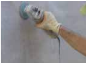
Élimination de la peau du béton
