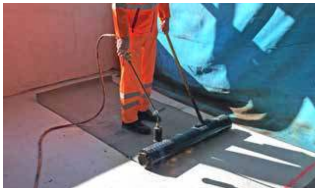
Flammage de membranes PBD
