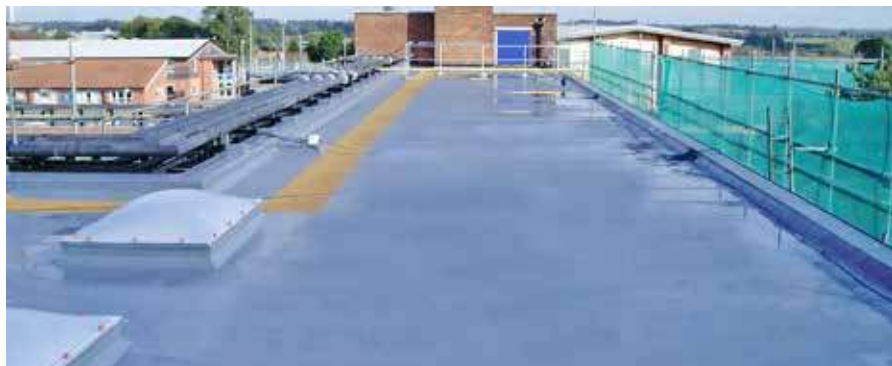
Toit plat étanchéifié
