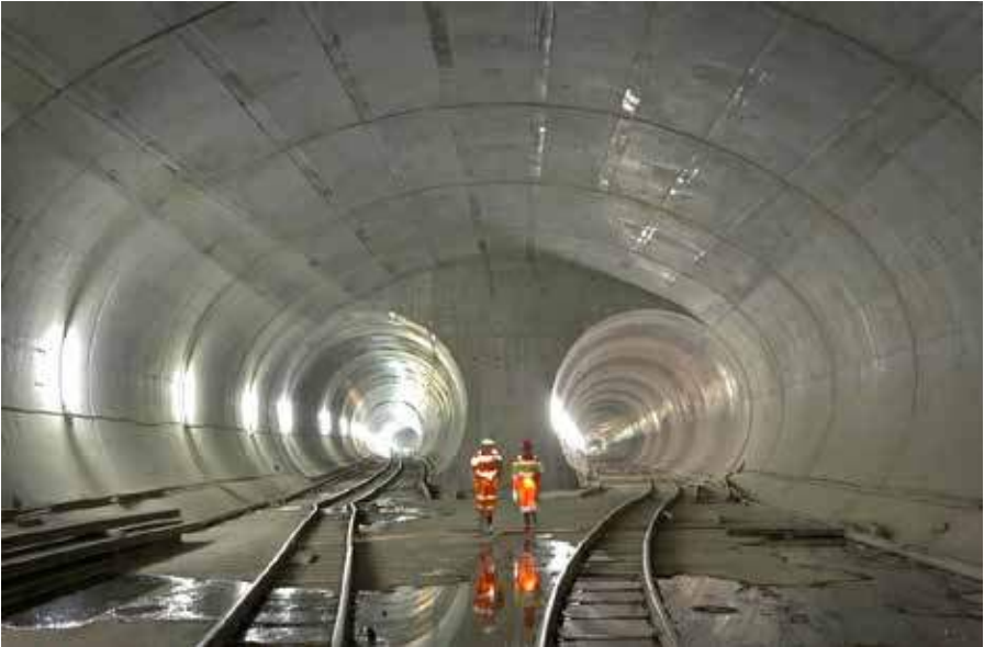
Tunnel de base du Saint-Gothard
