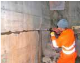
Perçage des fissures
