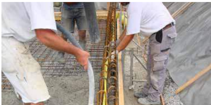
Pose de bandes d'étanchéité
