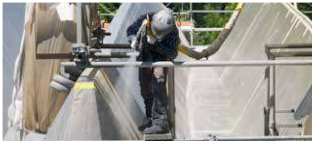
Application de polyuréa hautement réactif
