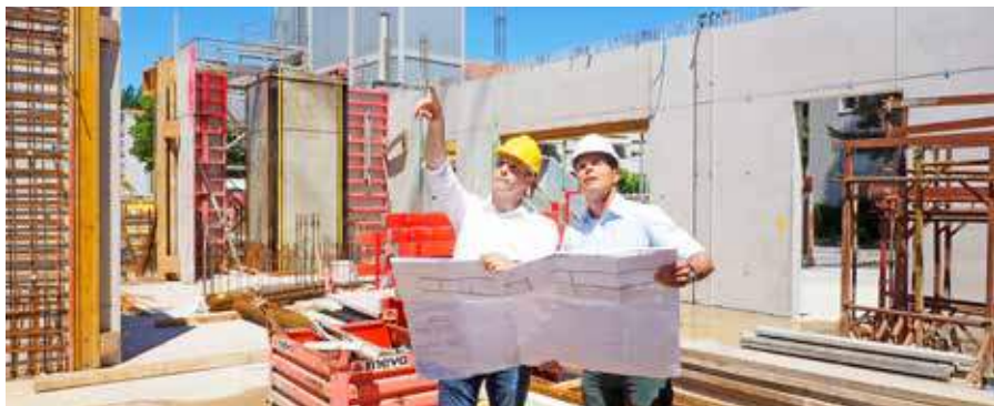
Contrôle sur le chantier
